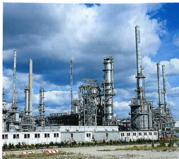
På olieraffinaderiet sendes olieprodukterne igennem rør til forskellige afdelinger, hvor de behandles. Nogle af beholderne på raffinaderiet indeholder katalysatorer.
